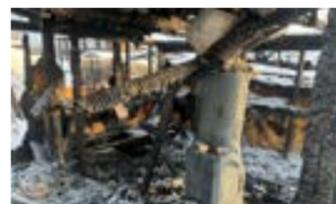
Причиной возникновения пожара явилась неисправность отопительной печи и дымовой трубы, в следствии деформации (просадки).
